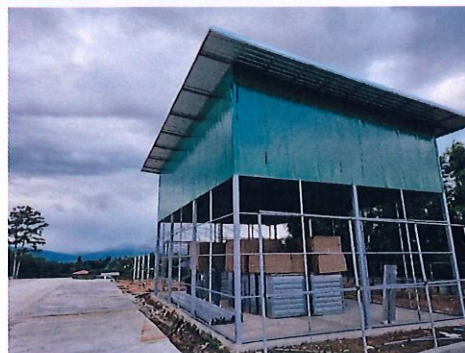
อาคารสำหรับติดตั้งเครื่องอบซีสต์ดอกสร้างแล้วเสร็จ
