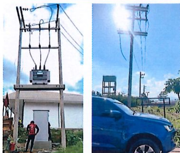
ระบบไฟฟ้าการเชื่อมต่อไฟและติดตั้งมิเตอร์
