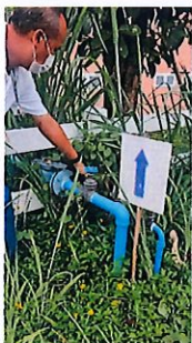
เตรียมวางระบบน้ำดิบ และน้ำประปา
